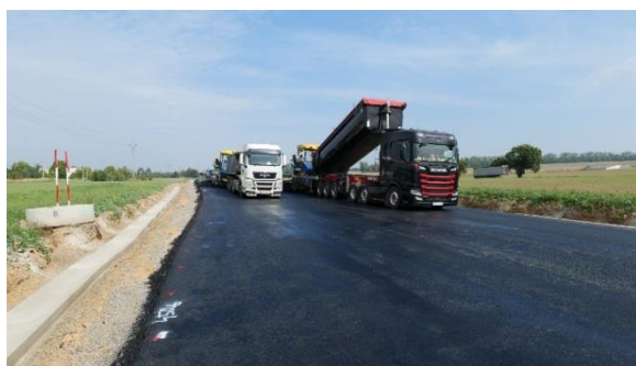
Obrázek 3 – pokládka asfaltových vrstev
